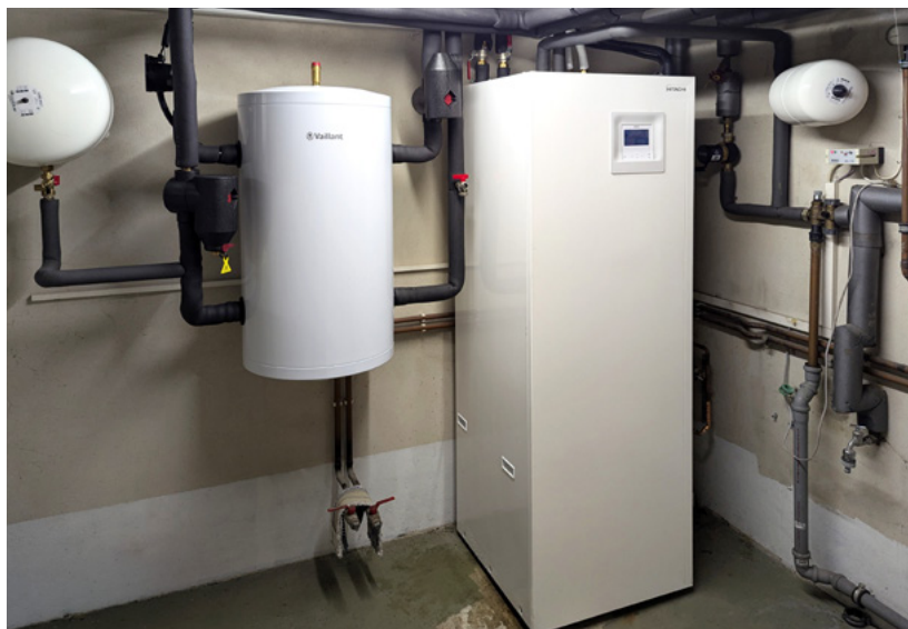
Das Kombimodul inklusive integriertem Warmwasserspeicher
