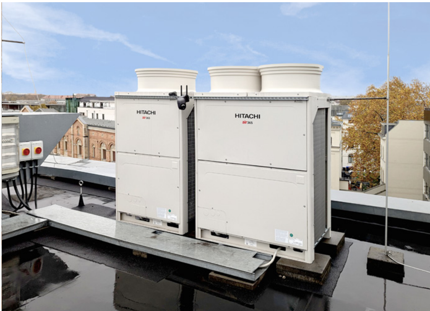
Hitachis neue air365 Max Außengeräte zum kompletten Austausch der bestehenden 3-Leiter-Anlage.
